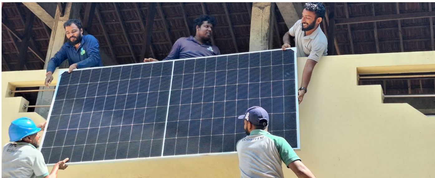
Solpanelerna lyfts upp för att monteras på taket till flickornas hus. Foto: Ramo
